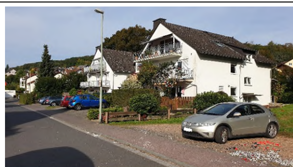
Foto 2: Bebauung im Langgraben 2-geschossig mit Satteldach
