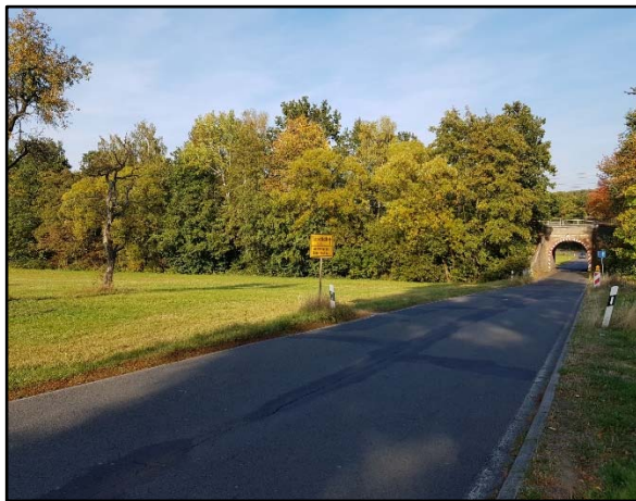
Blickrichtung Osten (Viadukt)
