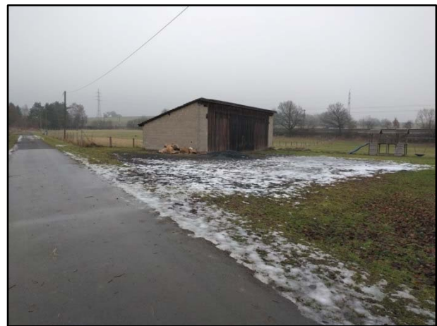
Südwestliche Potenzialfläche in Richtung Nordosten
